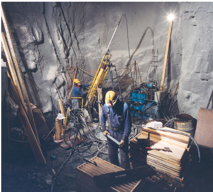
Diamantborrning under jord. Foto Boliden Mineral AB.
