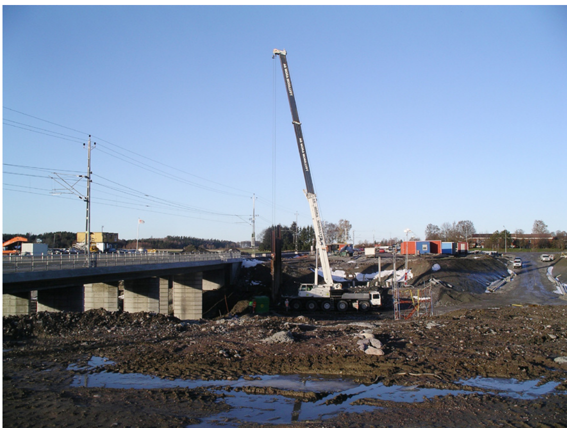
Bygge av viadukt och rondell för anslutning till nya E4:an förbi Uppsala. Foto: Åke Berg, SGU.
