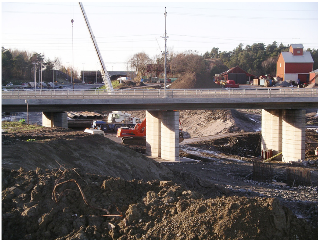
Järnvägsbro av betong och i bakgrunden arbete med ny vägtunnel för anslutning till nya dragningen av E4:an förbi Uppsala. Foto Åke Berg, SGU.
