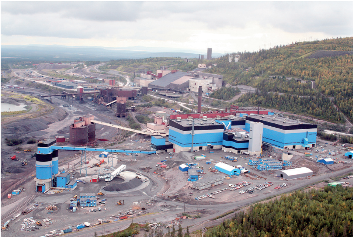
Nya pelletsverket MK3 i Malmberget. Foto: LKAB.
