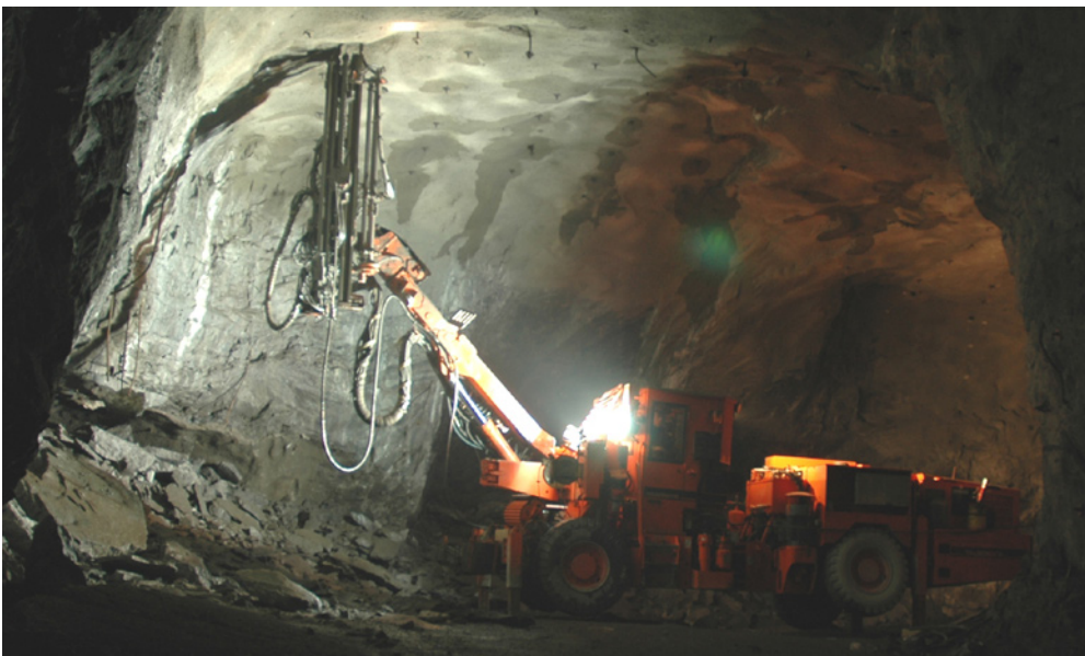
Borrningsarbeten. Foto: Boliden AB.
