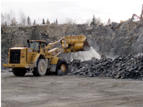
Fig 2. Efter sprängning bevattnas det loss hållna berget för att reducera damningen vid därpå följande utlastning och krossning.
