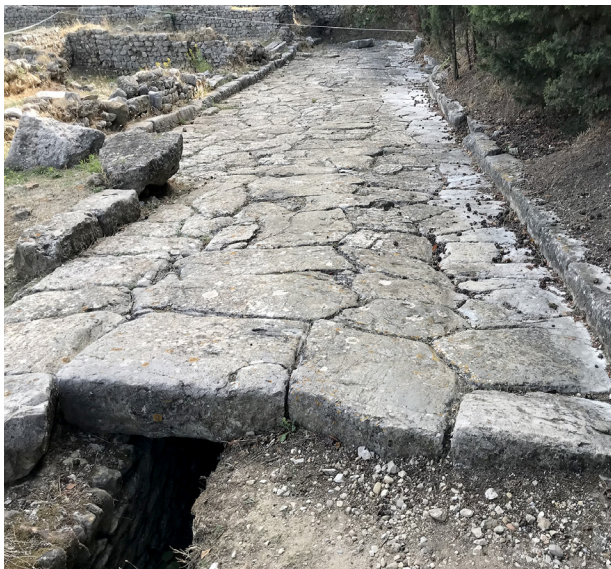
Figur 16. En 2 000 år gammal romersk väg som är konstruerad av tätt lagda lokala kalkstensblock. Understensättningen finns ett dräneringssystem för att leda vidare regn- eller avloppsvatten. Foto: Mattias Göransson, SGU.
