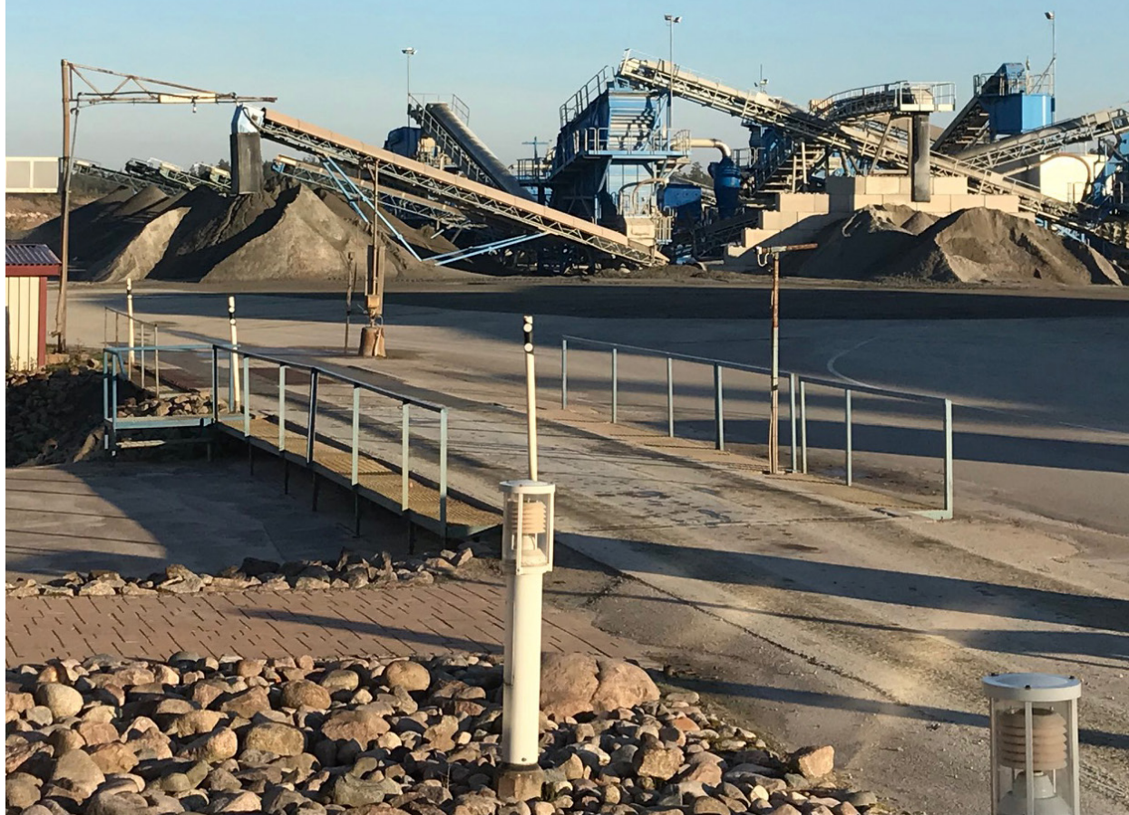
Efterkrossning och uppdelning av olika sorteringar som ska användas för betongtillverkning vid AB Nybrogrus anläggning vid Runtorp i närheten av Kalmar. Foto: AB Nybrogrus.
