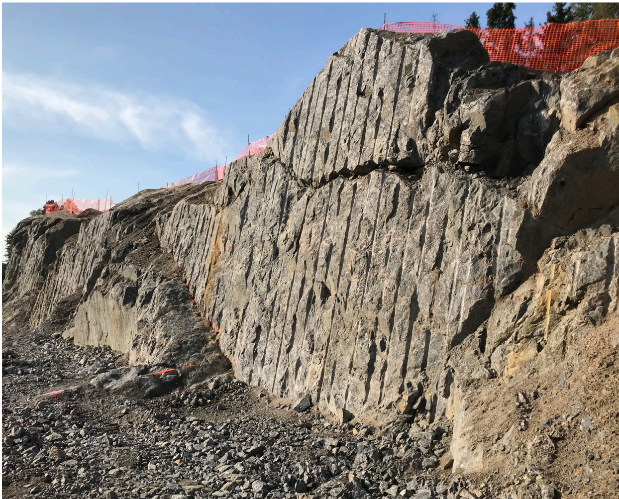
Figur 16. Årligen skapas stora mängder entreprenadberg som ofta delvis återanvänds direkt på plats. Överskottsmassor däremot, skulle om bergmaterialet har rätt egenskaper kunna användas som betongballast vilket indirekt skulle minska transportkostnaderna. Foto: SGU.
