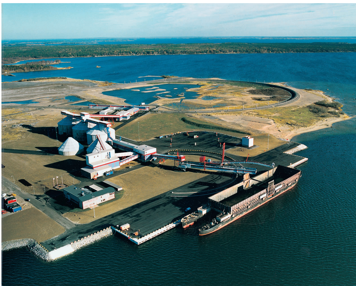
Figur 19. Ballastmaterial skulle kunna fraktas med fartyg i större utsträckning förutsatt att hamnarna var dimensionerade för skrymmande och tunga material som ballastmaterial. I Luleå hamn lastas malm på båt för vidare transport mot andra länder. Järnvägsanslutning till Luleå hamn är konstruerad för 30 tons axellast vilket är en förutsättning för att dessa tunga transporter ska vara möjliga. Foto: LKAB. Construction aggregates can be shipped longer distances provided that the ports can receive heavy bulky materials.
