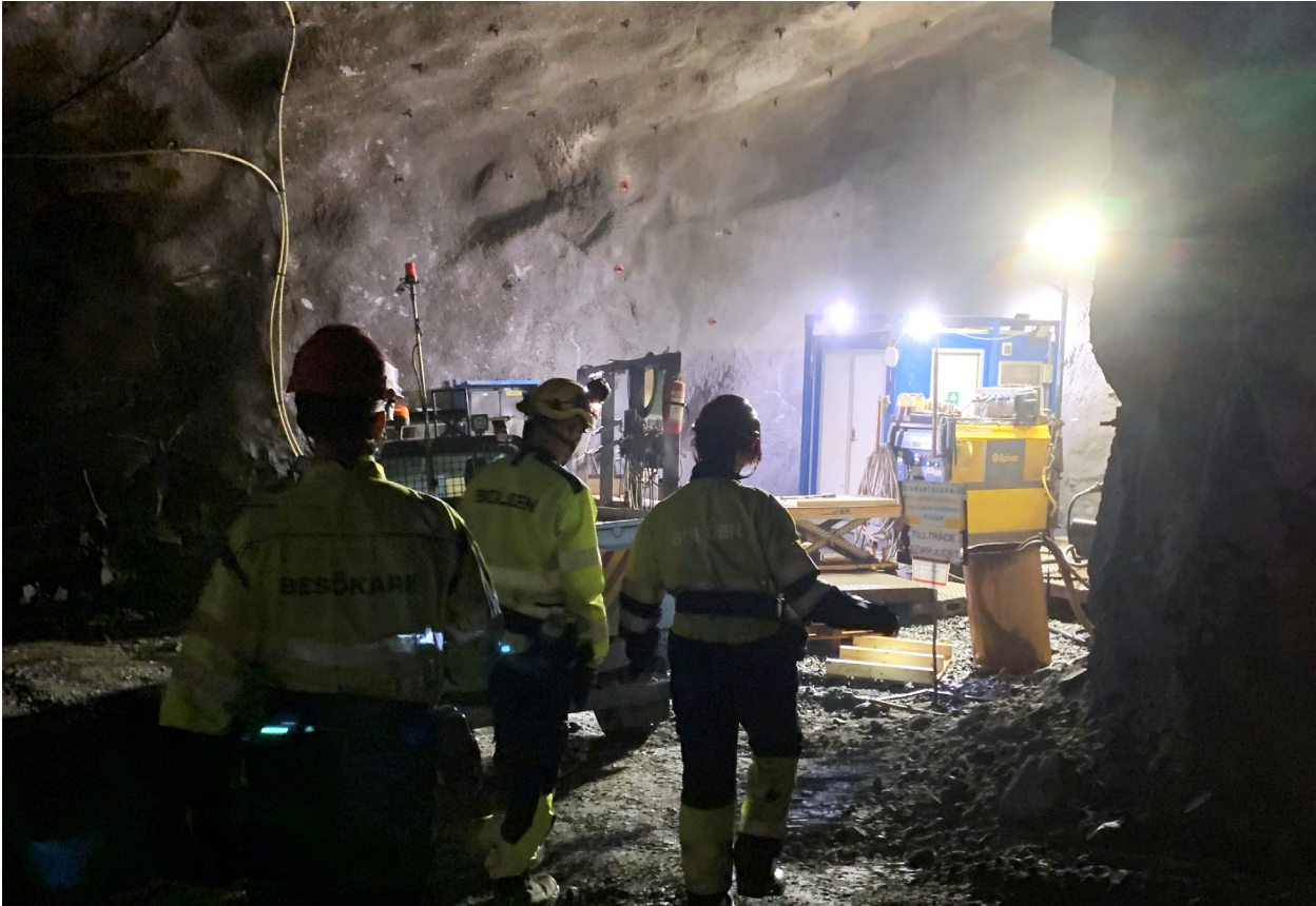
Borrning i Kankbergsgruvan där guld och tellur är de ekonomiskt intressanta ämnena. Foto: Carolina Liljenstolpe/SGU.
