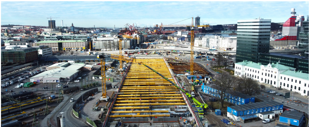
Figur 27. I samband med stora infrastrukturprojekt losshålles exempelvis lera vilket inte kan användas som byggnadsmaterial för det fortsatta byggandet. I stället behöver man transportera in nya bergmaterial. Drönarbild av byggandet av Centralen i Göteborg. Foto: NCC.
