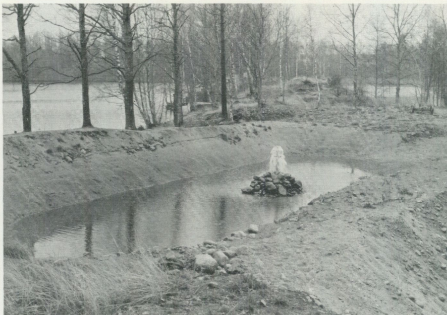
Fig. 8. Infiltrationsbassäng vid Traryds grundvattentäkt, Kronobergs län. Vatten från Lagan (i bakgrunden) förädlas genom infiltration och förstärker den naturliga grundvattentillgången i åsen. (foto R. Elfvig 1972)
