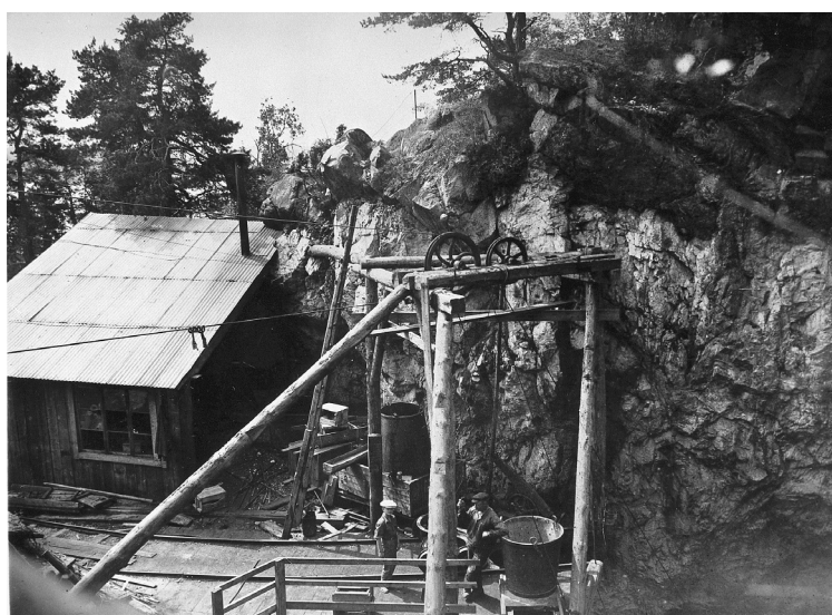
Fig. 15. Uppfordringsverket och t.v. smedjan. Bilden publicerad med tillstånd av Österåkers Hembygds- och Fornminnesförening.
