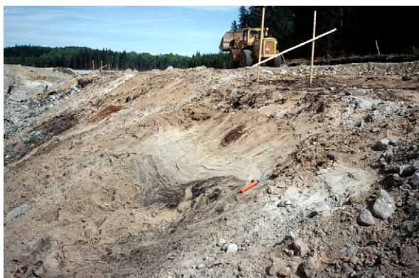
Fig. 83. Sand med torvsikt vid Jacobs sjö överlagras av skiktad sand. I den överlagrande sanden förekommer droppjord och körtlar av organogena sediment. Denna provtagningsplats överlagrades före schaktningsarbetena av 4 m torv.
