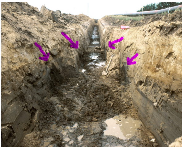
Fig. 11. Foto av gasledningsschaktet O Krontorp taget i riktning mot norr. I lagerföljden ingår ett veckat organogent lager. Vecken i denna lagerföljd visas med pilar. Schaktet är knappt 2 m djupt. De organiska sedimenten når ner till djup större än detta men deras undre delar har inte kunnat observeras.
