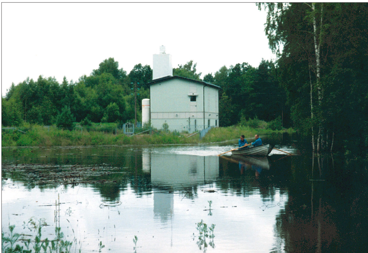
Översvämningar kan leda till förorening av en vattentäkt. Sommaren 2004 översvämmades grundvattentäkten i Alvesta och ytvatten trängde ner i fyra av de fem brunnarna vilket ledde till att vattnet förorenades. Foto: E. Winnfors, Cirkulation.
