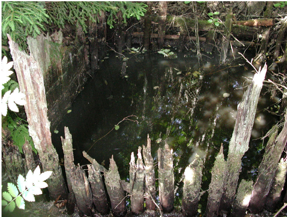
Fig. 50. Nysundsgruvan 2 är ett gott exempel på de små timmerstämplade gruvorna i norra delen av Baståsfältet. Foto: Nils-Gunnar Wik.
