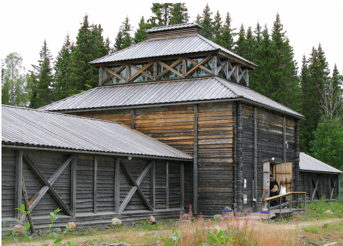
Fig. 49. Gruvöverbyggnaden vid Los koboltgruva inrymmer idag gruvmuseum m.m. Foto: Arne Persson. The superstructure of the Los cobalt mine now houses, among other things, a mine museum.
