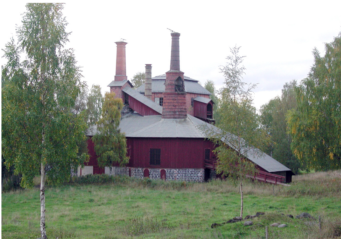
Fig. 14. Movikens masugn med två rostugnar, den nya runda och den gamla fyrkantiga. Foto: Nils-Gunnar Wik.
