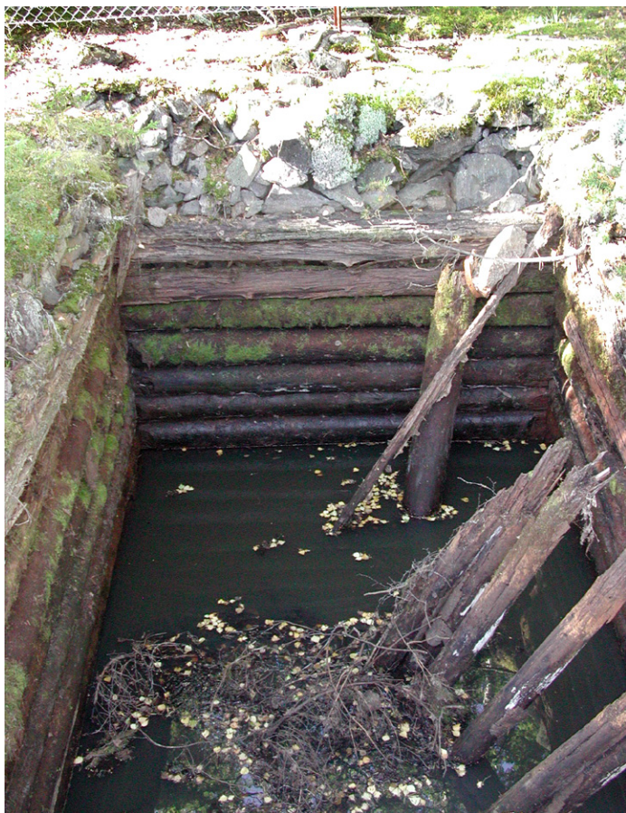
Fig. 23. Hällgruvans timmerskodda schakt fotograferat mot väster. Foto: Nils-Gunnar Wik.
