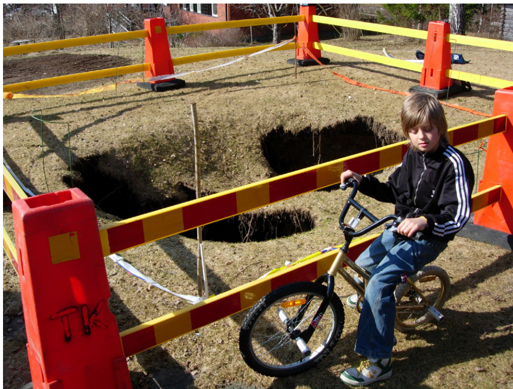
Fig. 11. Våren 2006 skedde ett ras i den gamla försöksgruvan Svedjebacksgruvan och då uppstod en ca 5 m djup krater med ca 5 m diameter i markytan, endast några meter från en av villorna. Foto: Arne Sundberg.
