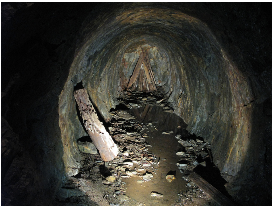
Fig. 48. Tillmakad ort i Los koboltgruva. Foto: Arne Persson.
