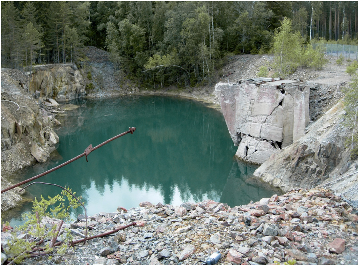
Schaktet och dagbrottet vid Nya Kalvsbäckens gruva, som bröts till 480 m djup är nu vattenfyllda. Rester av betongschaktet syns till höger i bilden.
