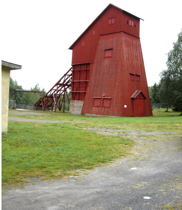
Vintjärns gamla lave (gamla centralschaktet) med snedbanan. The old wooden main frame at Vintjärn.
