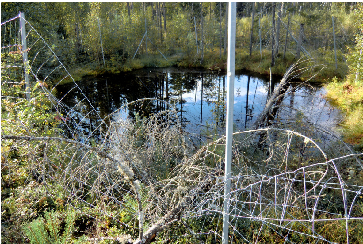
Trasig gruvinhägnad vid Dimbon 2 på grund av kullfallet träd, en vanlig syn vid många gruvor. Broken fence surrounding the Dimbon 2 mine.
