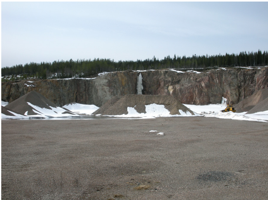
Krossbergstäkt vid Gärsbukölen. Bergarterna är deformerad felsisk vulkanit, granit och basit.
