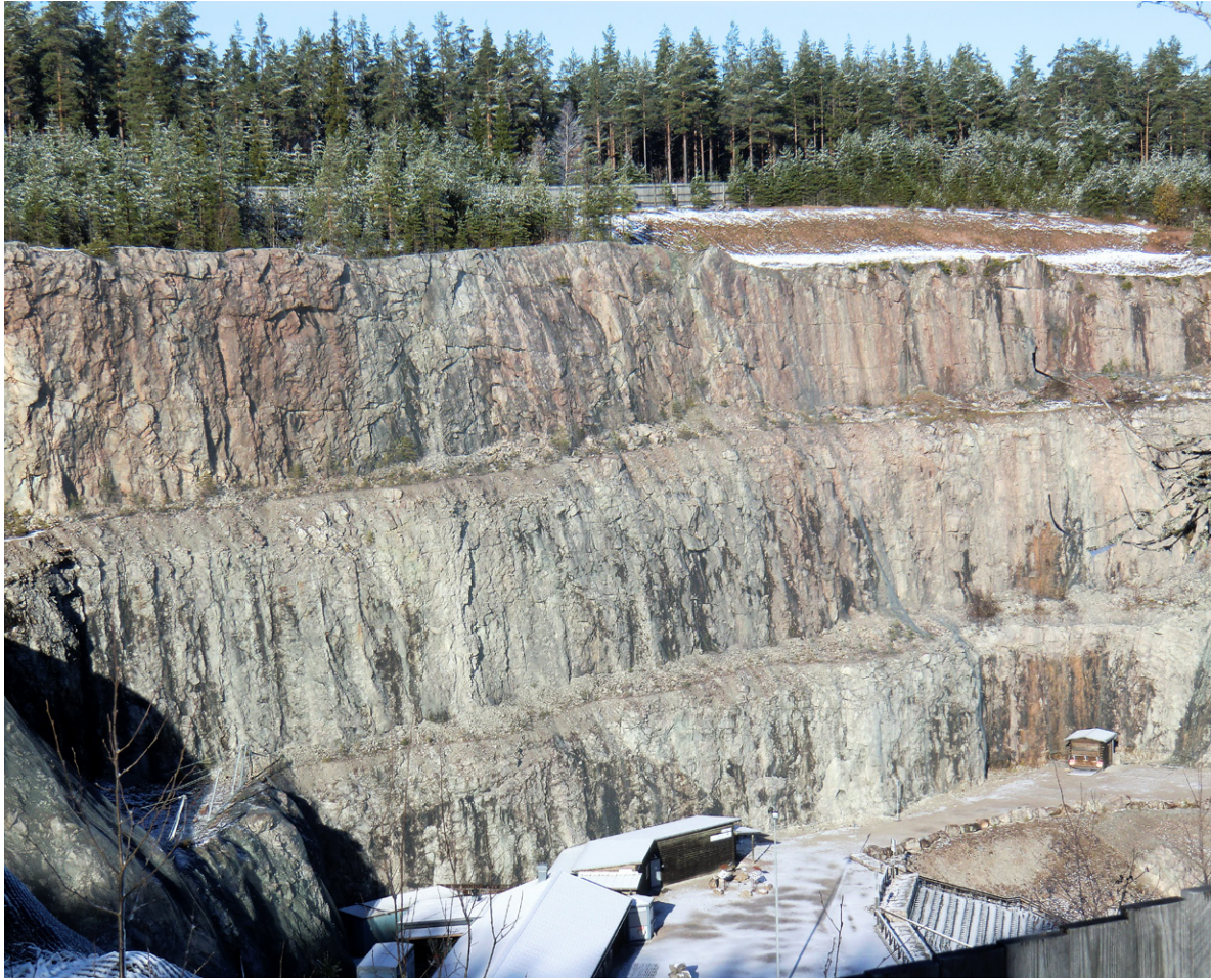
Det nu nedlagda kalkstensbrottet vid Draggängarna används numera som naturteater med namnet Dalhalla. The abandoned limestone quarry at Draggängarna is today used as open-air theatre (Dalhalla).
