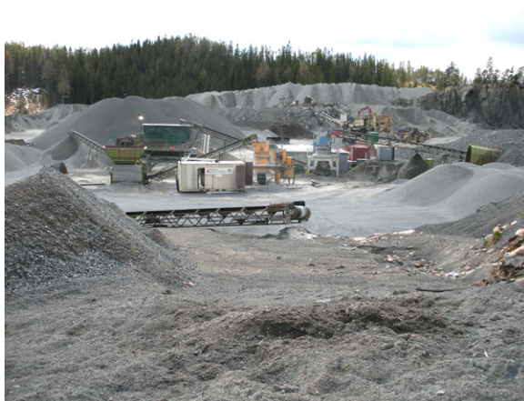
Högbergets krossbergstäkt. The aggregate rock quarry at Högberget.
