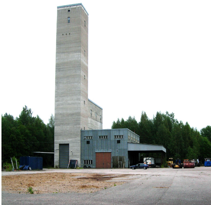
Nya centralschaktet i Vintjärn med gruvlaven i betong färdigställdes 1966 och användes för all malmuppföring fram till nedläggningen av gruvan 1978.
