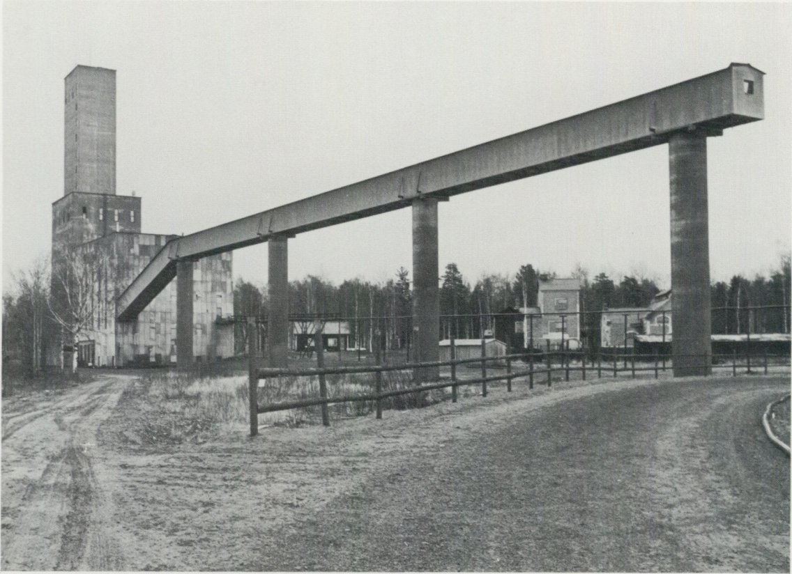
Mimergruvans lave 1986 med anrikningsverk och transportband för järnslig.
