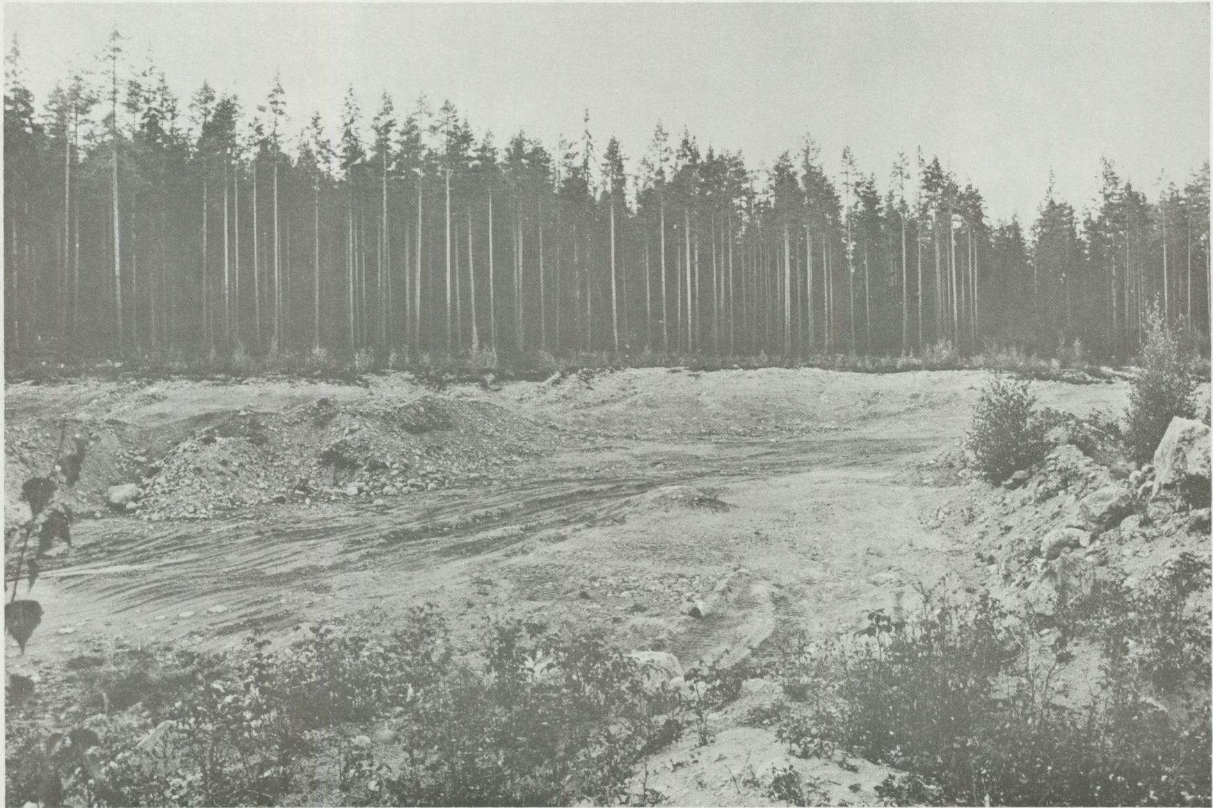
Foto 7. Förekomst 12 E Blackstahyttan. Översiktsbild av grustäkten 500 m sydväst om Blackstahyttan. Täktens botten utgörs av finkorniga sediment (finmo och lera). (Foto B. Ericsson, 1976)
