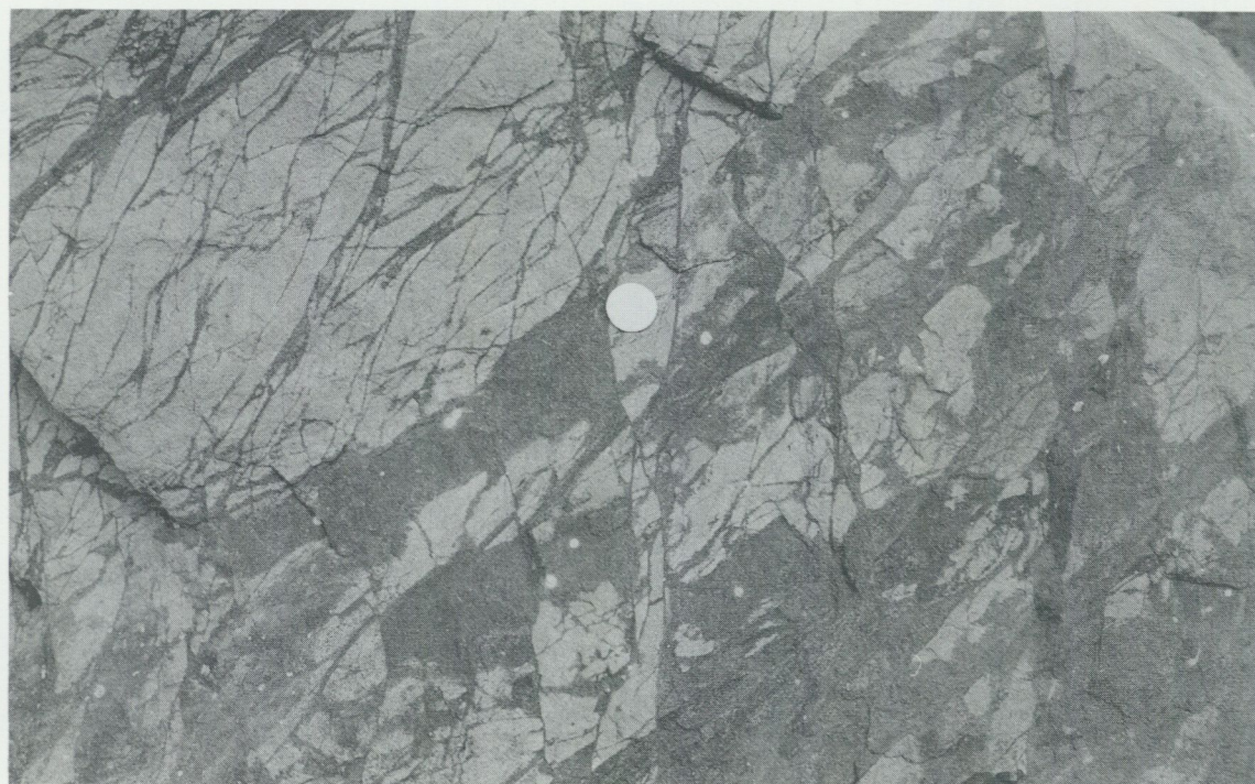
Fig. 4. Kraftigt uppsprucken Visingsösandsten intill förkastningen utmed Skagerns sydöstra strand. Häll nära Rörvik.
