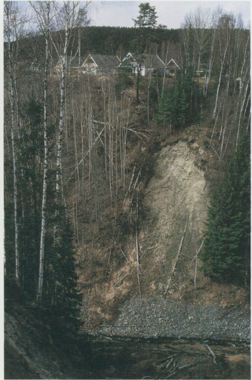
Fig. 14. Släntskred i den djupa Skedomravinen, Sollefteå. Sprängsten har lagts ut som erosionskydd. Foto förf. 1995.
