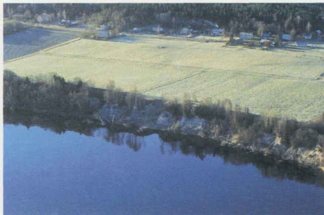
Fig. 16. Sommaren 1995 skedde ett relativt stort släntskred vid Ångermanälvens nedre lopp söder om Grillom. Skredet var ca 200 m långt och 5 m brett. Slänten är relativt låg, ca 5 m hög. Älvens vattenyta ligger nästan i nivå med havsytans. Foto Sollefteå kommun 1995.
