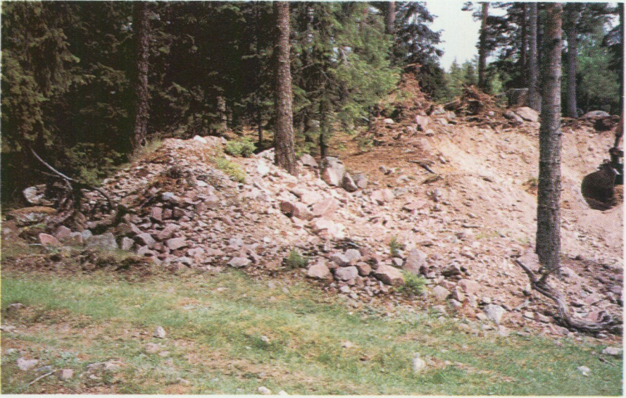
BÖRJE Uppschaktat material från närbelägen täkt.
