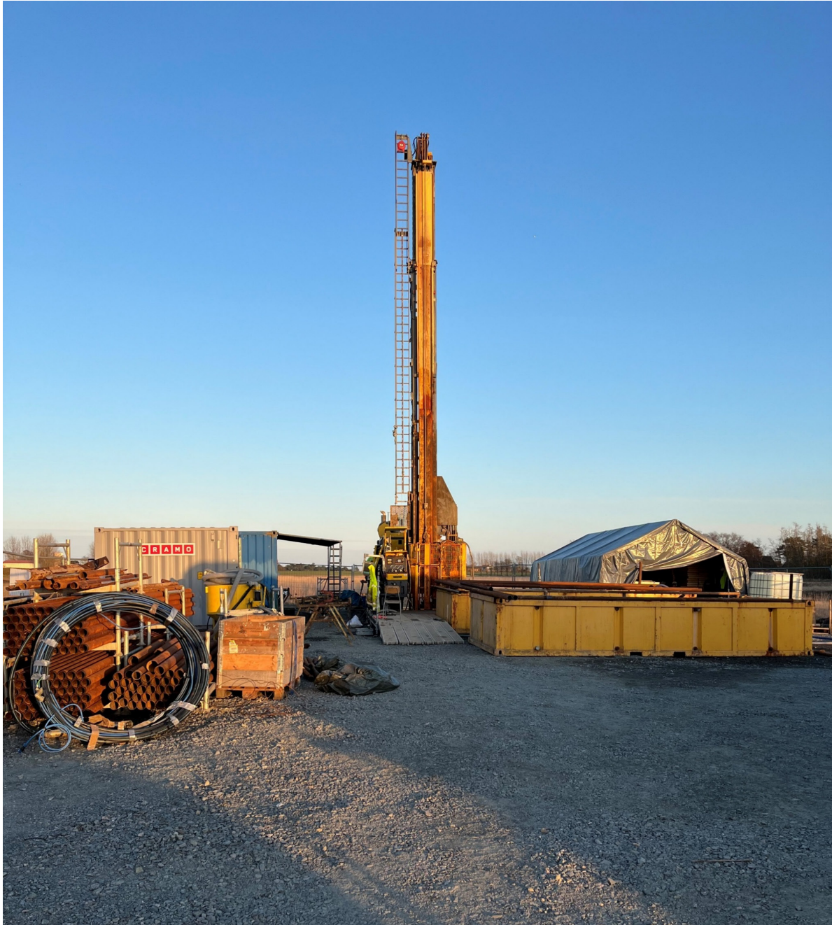
Figur 9. Kärnborrning med Riksrigger i Skåre, väster om Trelleborg, mars 2025. Foto: SGU.
