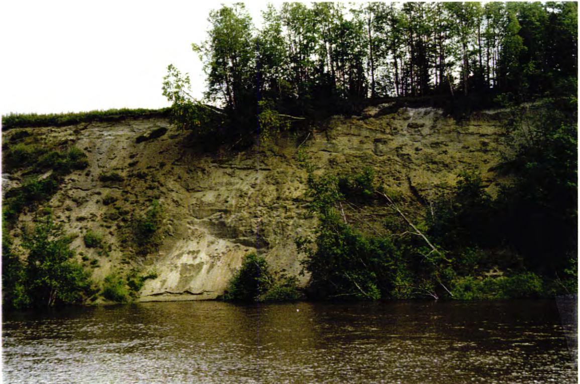
Fig. 7. Nipbildning i skredärret. Foto C. Fredén 2001.
