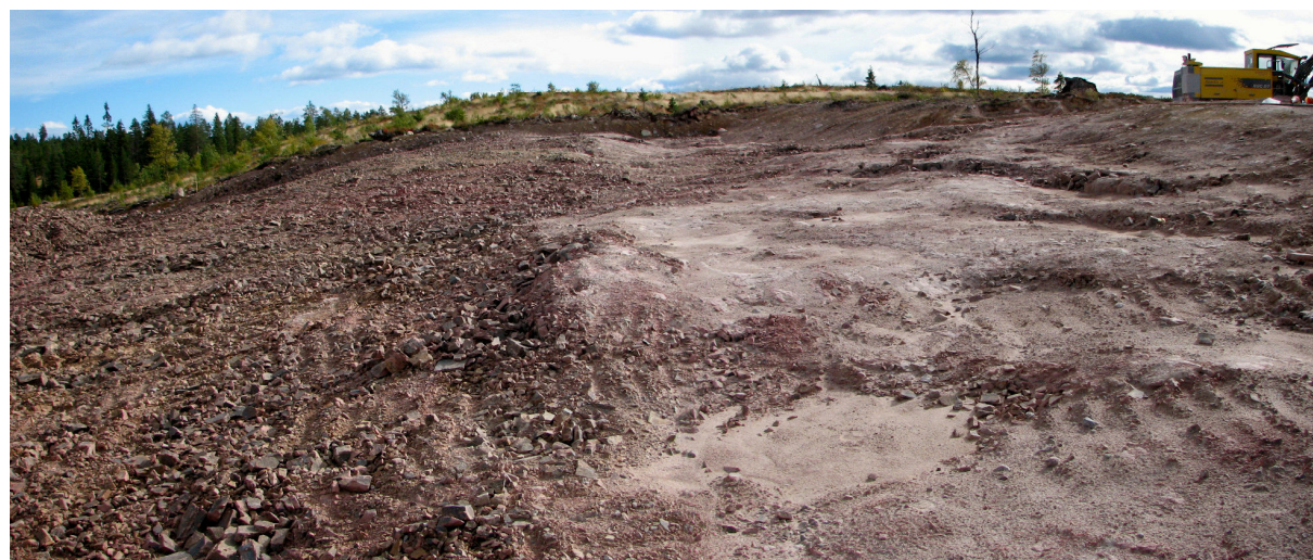
Fig. 3. Bilden är tagen mot söder och visar den avschaktning som skett av taktområdets morän och delar av porfyrbergets uppspruckna ytlager till vänster.
