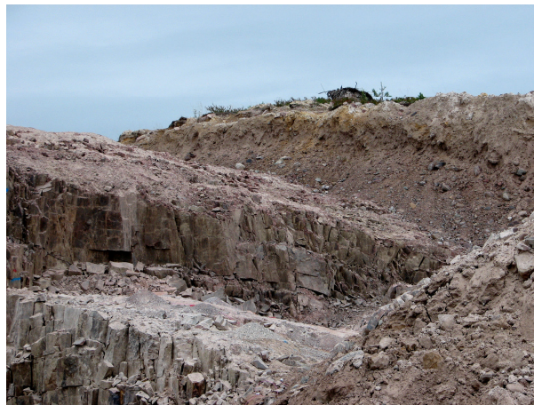
Fig. 5. I tåktområdets högsta del samt i slutningen mot väster har 1 à 2 m mäktig, sandig morän avschaktats.
