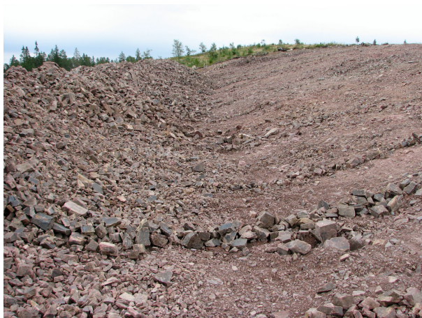
Fig. 4. Ytschaktningen av slutningen mot öster har skett i rektangulärt uppsprucken porfyr. Block i ytan och täckande moränlager saknas i denna ostslutning.
