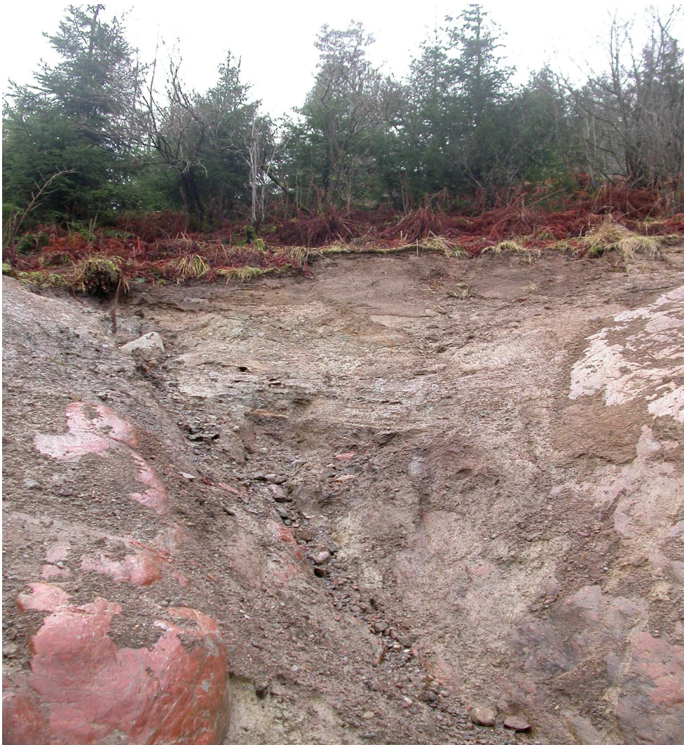
Fig. 5. Framgrävd skärning i den västra sluttningen vid Småröd. Friktionsjord under glacial lera. Mäktigheten på friktionsjorden är ca 3 dm i lågpunkten medan den glaciala leran ligger direkt på berget i övrigt. Foto M. Engdahl 2007.
