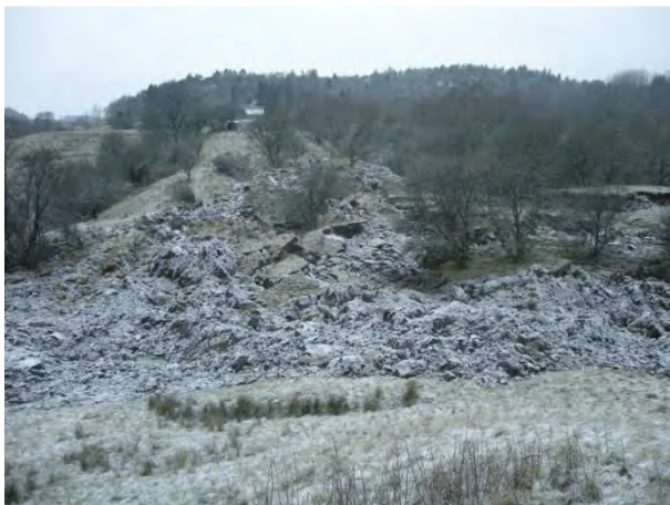
Figur 17. Skredets nedre sydöstra del där massorna från både den södra och östra dalgången ansamlats. Till höger i bild syns det relativt ostörda partiet som är markerat på bild 5, bilaga 1.
