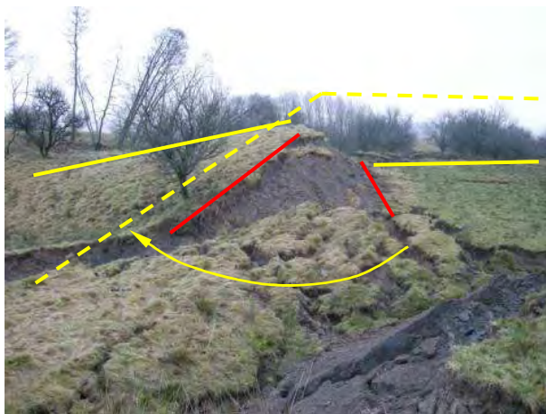
Figur 5. Rotationsskålla i skredets östra kant. Till vänster i bilden den nu helt igenfyllda östra dalgången. Röda kanter har suttit ihop. Gul streckad linje visar ursprunglig markkontur, gul heldragen visar nuvarande.
