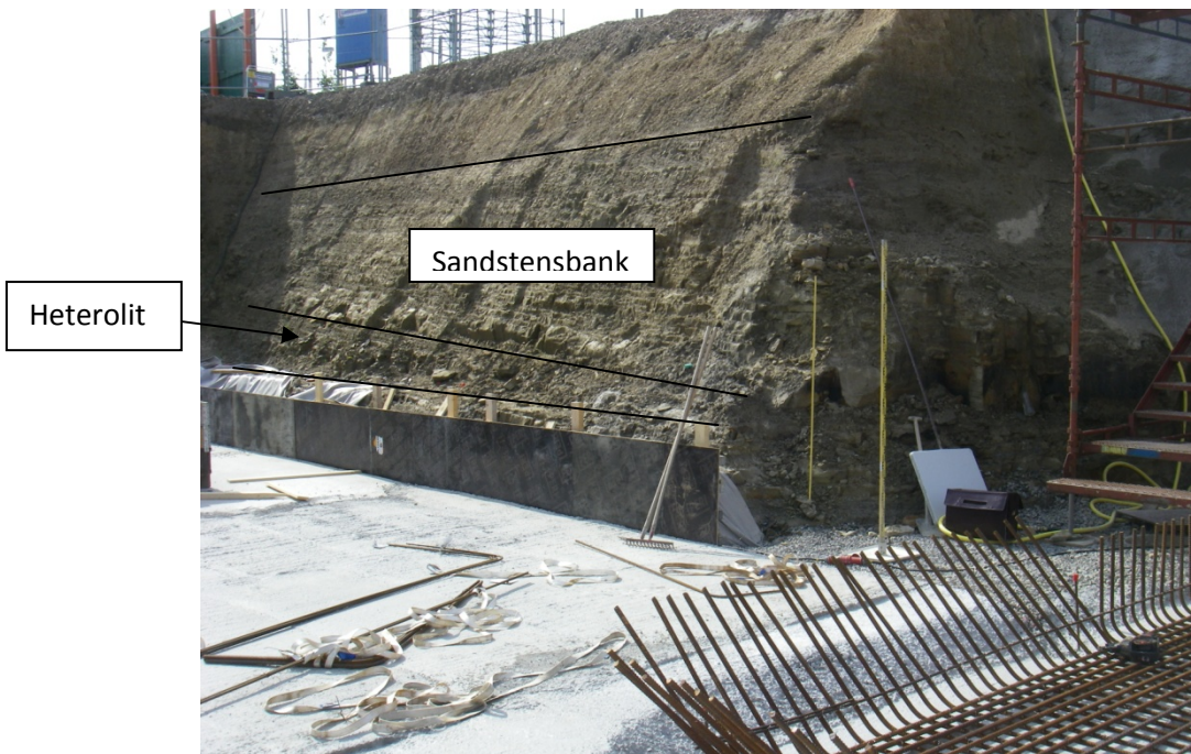
Figur 4. Sydvästra väggen. Sandstensbank och heteroliter är utmärkta på bilden.
