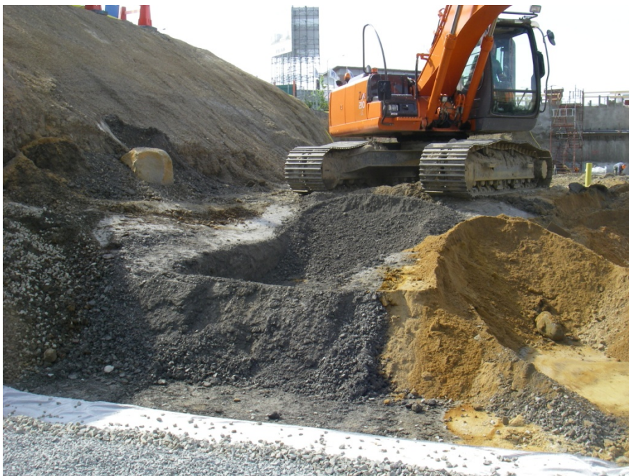
Figur 8. Bild åt sydväst, profil 8. Från nordost (vänster i bilden) heteroliter som stupar ca 20° åt öster, svart siltig lera (juralera) samt isälvsmaterial (brunfärgad sand och grus). Notera den skarpa avgränsningen mellan isälvsmaterial och juralera.
