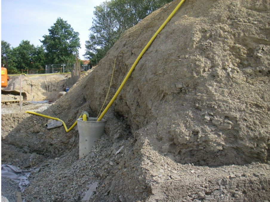
Figur 7. Bild åt nordväst, parallellt med schaktslännt. I hörnet är profil 7 uppmätt. Veck i heteroliter med veckaxel i nordnordostlig riktning. Berggrunden är förskjuten ca 50 cm nedåt på nordvästra (vänstra) sidan av vecket jämfört med sydöstra.
