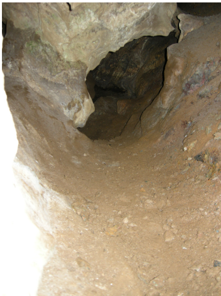
Fig. 26. Foto inifrån den knappt kvadratmeterstora öppningen nedanför pilen och alldeles ovanför mitten i fig. 25 visar att brytningen fortsatt flera meter i nordöstlig riktning. Foto: Nils-Gunnar Wik
