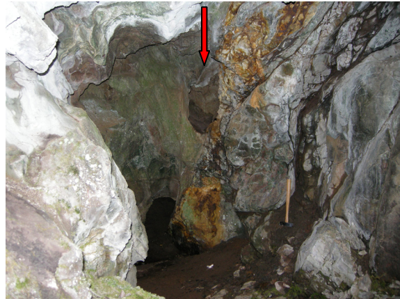
Fig. 25. Det brantstående sulfidmineralmineraliserade lagret i Svedbergagruvan och en knappt kvadratmeter stor öppning i ortens bortre vägg, nedanför pilen. Foto: Nils-Gunnar Wik
