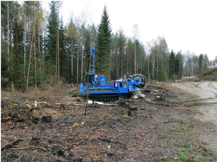
Figur 10. Etablering av rör 3 vid Öjesjövägen i oktober 2014. Skogen väster om röret stod kvar och var relativt opåverkad av branden. Foto: Kajsa Bovin.
