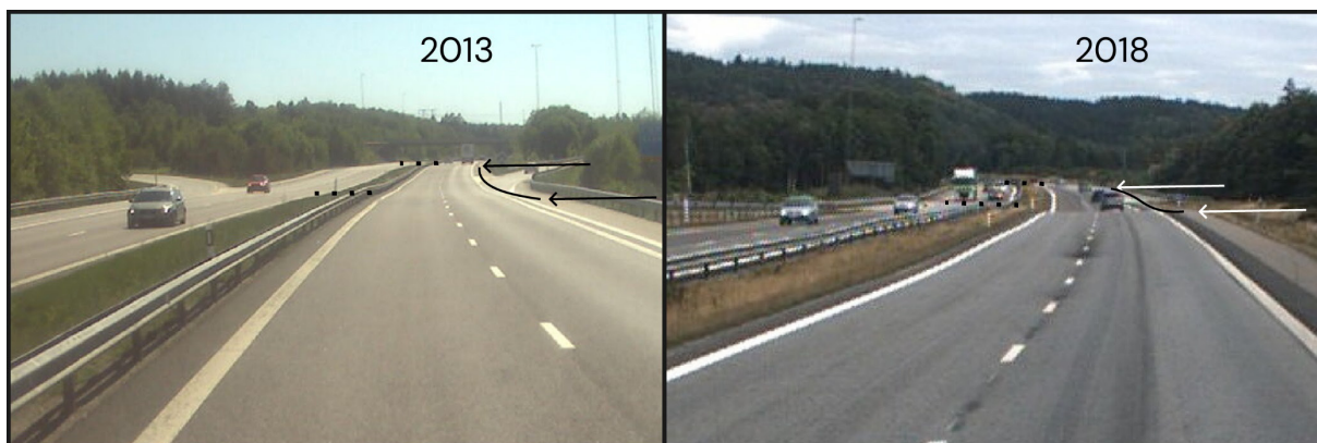
Figur 57. Foton från Trafikverkets övervakningsprogram åskådliggör sättningssvackan år 2013 och 2018. Pilar markerar höjdpunkterna var emellan de största sättningarna inträffat. Foto 2013 visar södergående körbana, med 'strykjärnet' på höger sida, och foto 2018 är i norrgående riktning. Foto: Trafikverket.
