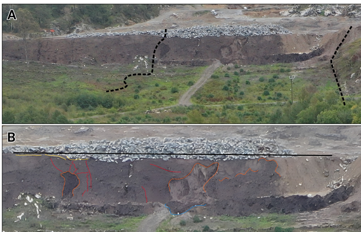
Figur 54. Vallen som byggdes upp vid uppfyllandet i den östra delen av skredområdet visar spår av erosion. Svartstreckade linjer i (A) markerar var skredärret utbildades. Linjer i (B) representerar en tolkning av små skred (orange), sprickbildningar (röd), skredavsättning (blå), sättning (gul). Svart linje föreslår en tänkt horisontell yta, utifrån vilken massorna förefallit sjunkit. Foto: M. Berglund, 2023-09-20.
