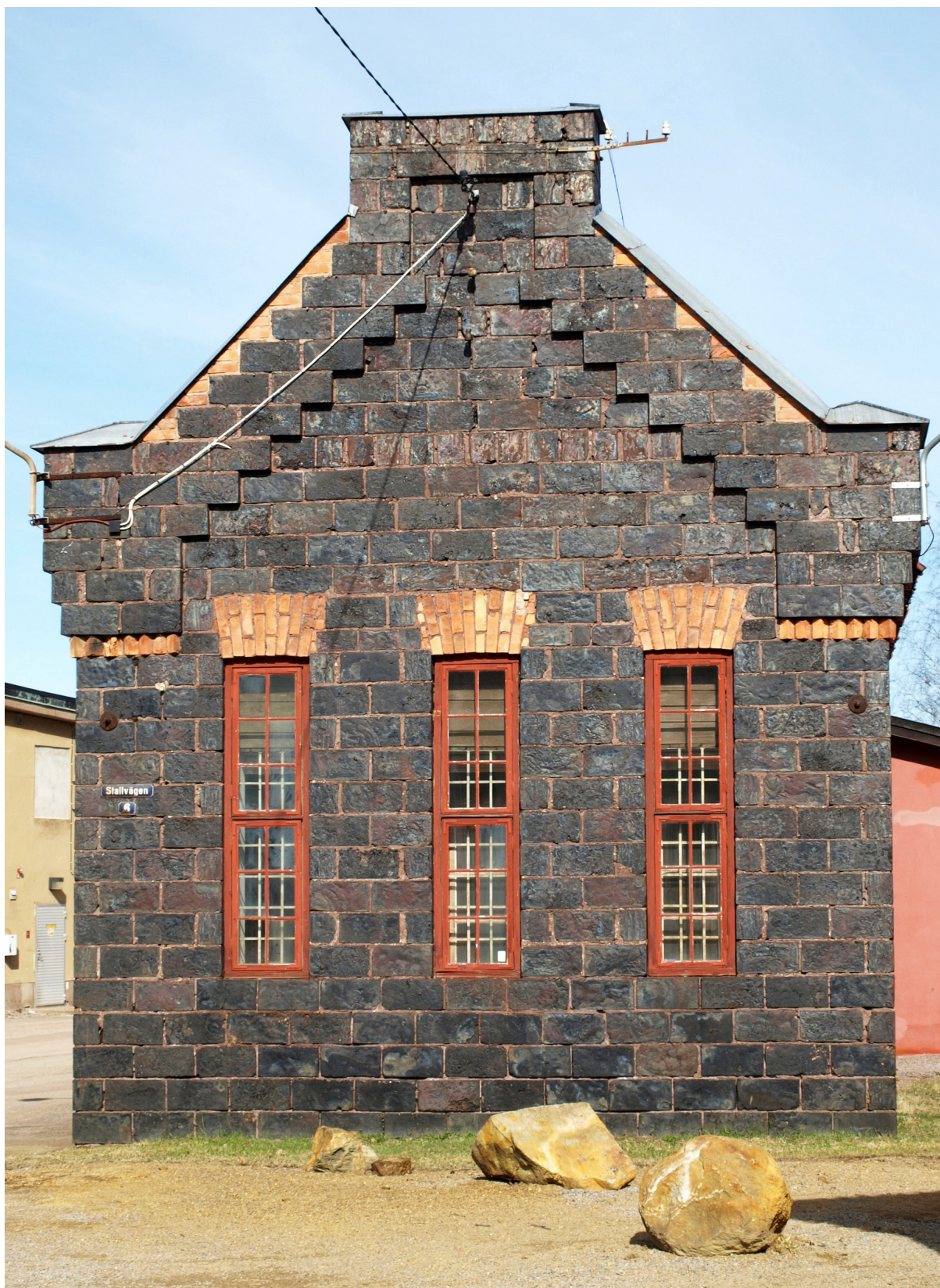
Figur 4. Exempel på historisk byggnad av gjutna, mörka slaggblock – så kallat "slaggtegel" – invid Stora Stöten, Falu koppargruva, Falun. Bågarna över fönstren och taket med mera utgörs dock av normalt tegel. Foto: Erik Jonsson.
