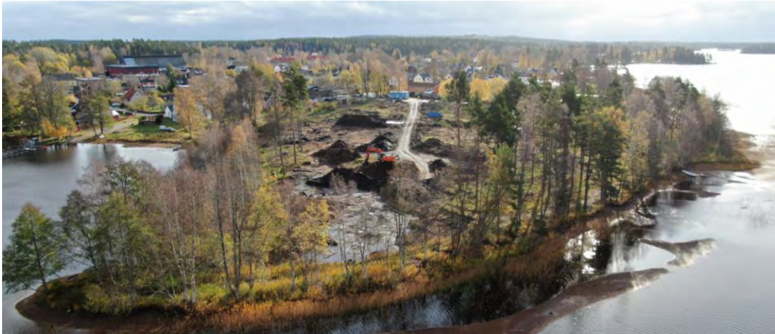
29 oktober. Väg byggd och sanering påbörjad i norr
