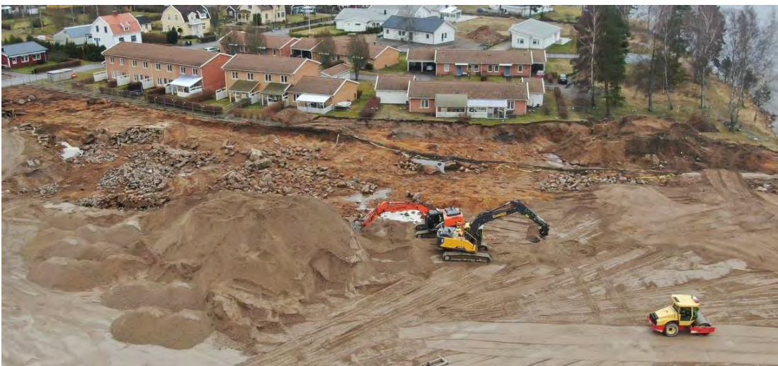
23 mars. Arbete med förorening i söder. Förorenat mörkt lager ses i slänt framför hus.
