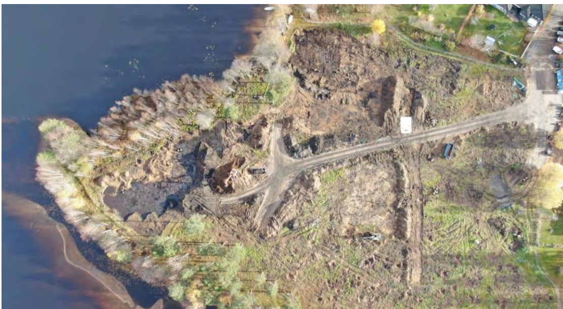
29 oktober. Väg med vändplats samt stickväg mot väster byggda. Övre lagret hopskrapat i öster, urgrävning ner till ren torv i norr.
