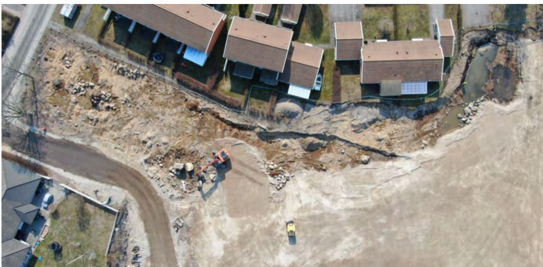
4 april 2019. Träd fällda och sanering utökad mot söder – ned till grundvattenytan.
