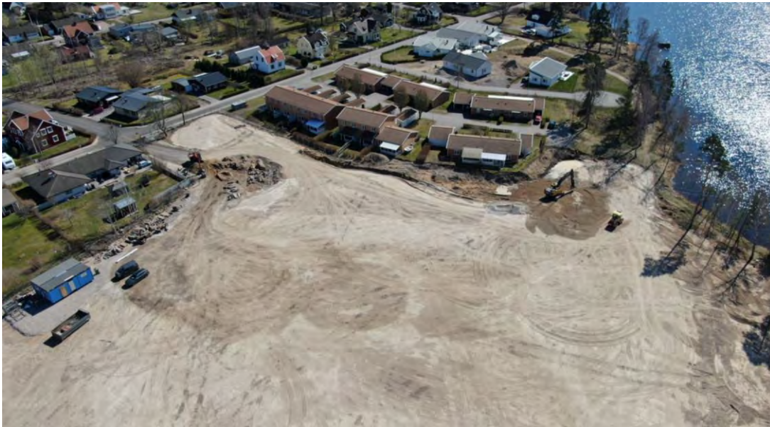
8 april. Endast mindre del i sydost och sydväst återstår att avsluta och återfylla.
