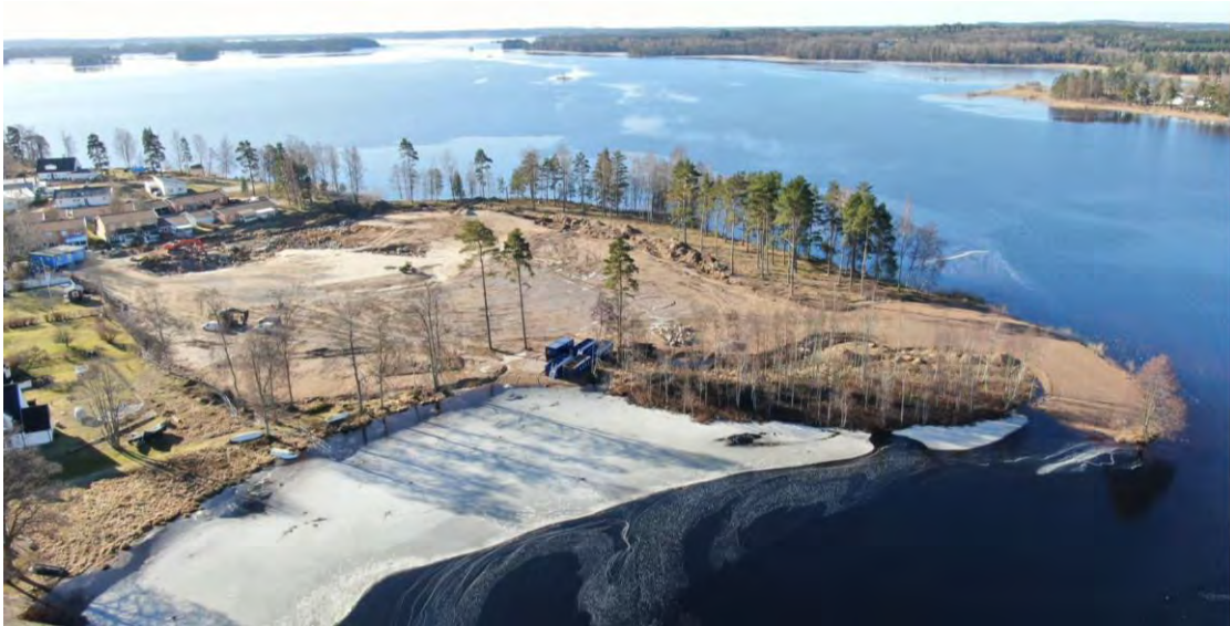
1 mars 2019. Is på Rottnen, vattenreningsanläggningen syns mitt i bilden.
