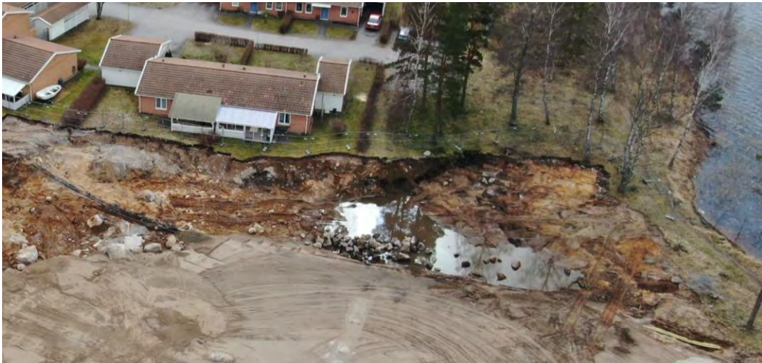
28 mars. Grävning ned till grundvattenytan i söder.
