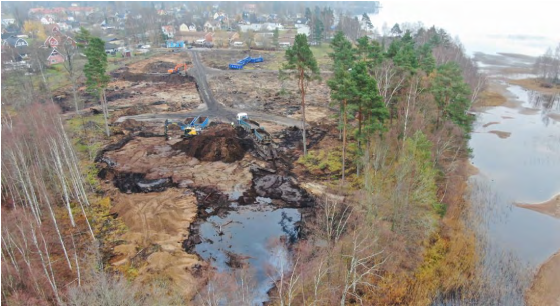
9 november. Torv lagt i hög för bortkörning. Låg vattennivå i Rottnen.
