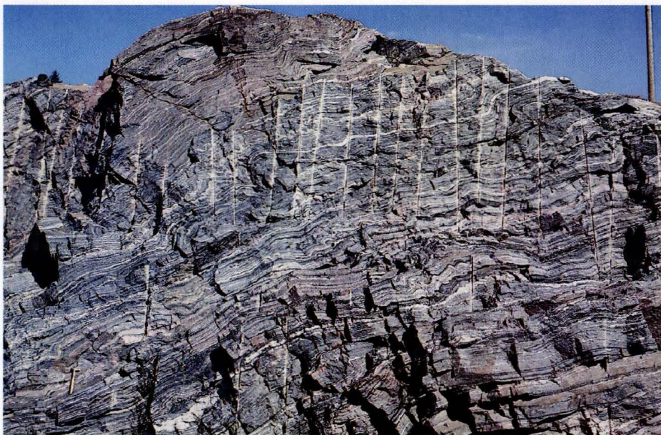
Färgbild 4. Efter kilsömborring förspärkt och sedan framsprängd skärning genom plastiskt veckad bandgnejs, en vanlig bergart i Hammaröformationen och västligare delar av södra Värmlands berggrund.
