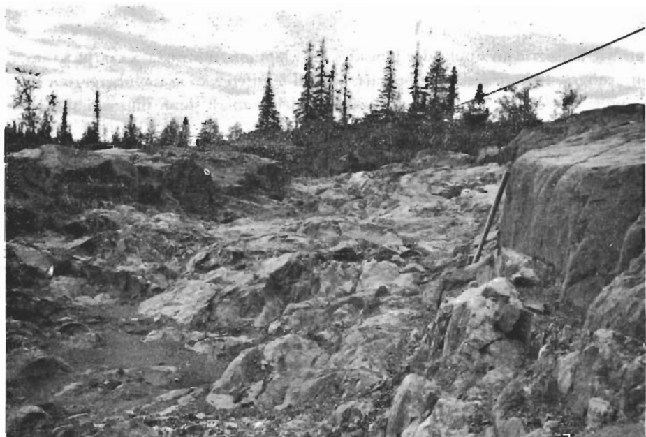
Fig. 74. Inlagring av skapolitiserad leptyt (i mitten av bilden) i blodsten. Ö om Storgruverymningen. Intercalation of scapolitized leptyte (in the middle of the picture) in hematite ore. E of Storgruverymningen
