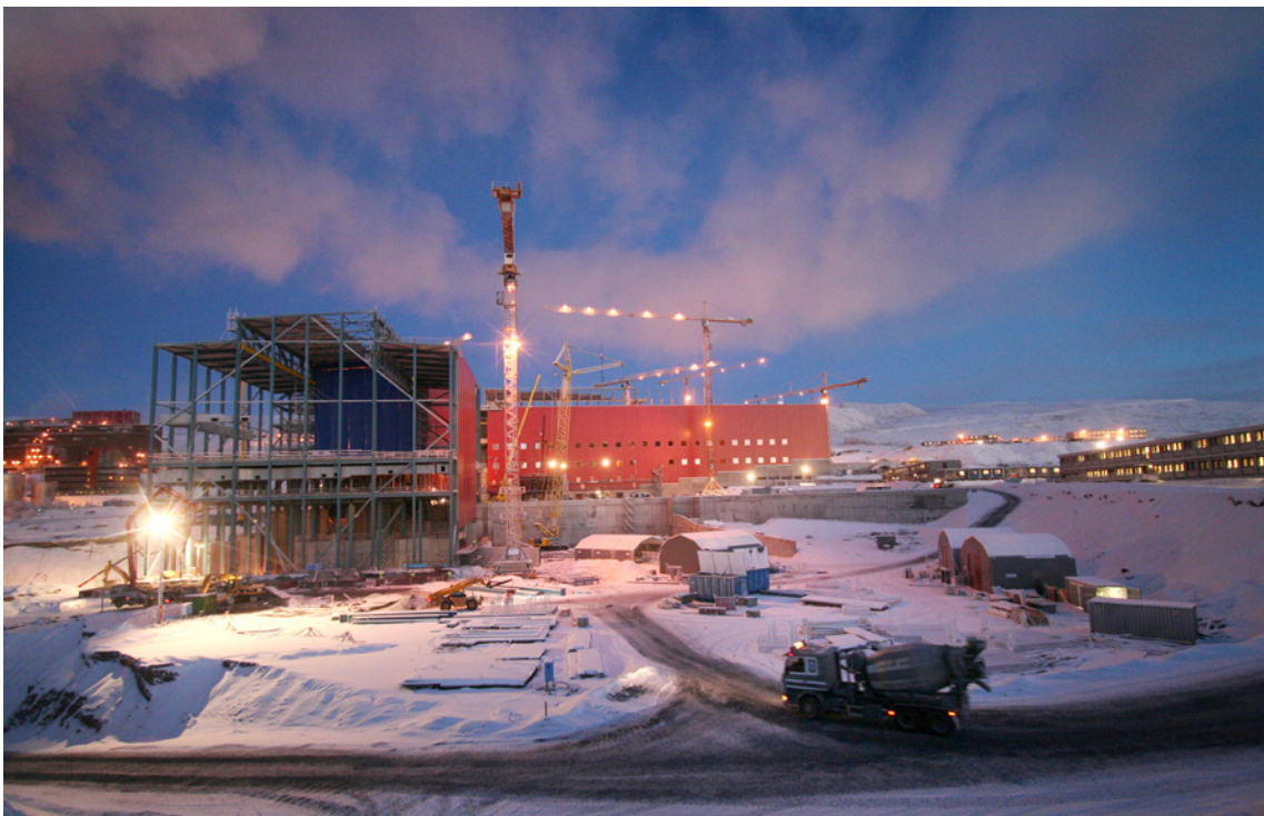
KA3/KK4-projektet i Kiruna med pelletsverket i förgrunden och anriktningsverket i bakgrunden. Foto: LKAB.
