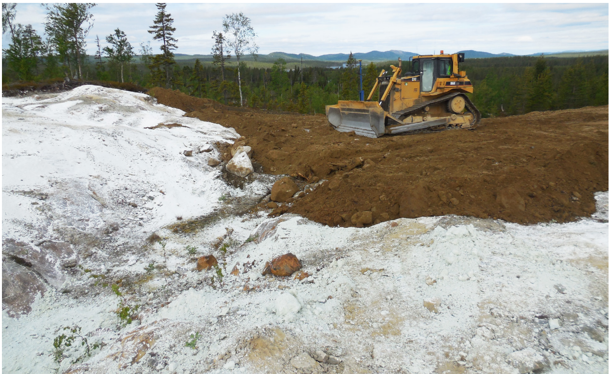
Återställning av Svärtrräskgruvan. Pågående återfyllning av det mindre dagbrottet där man ser kalk som lagts på ytan innan återfyllning med morän. Foto: Göte Larsson, Bennys gräv.
