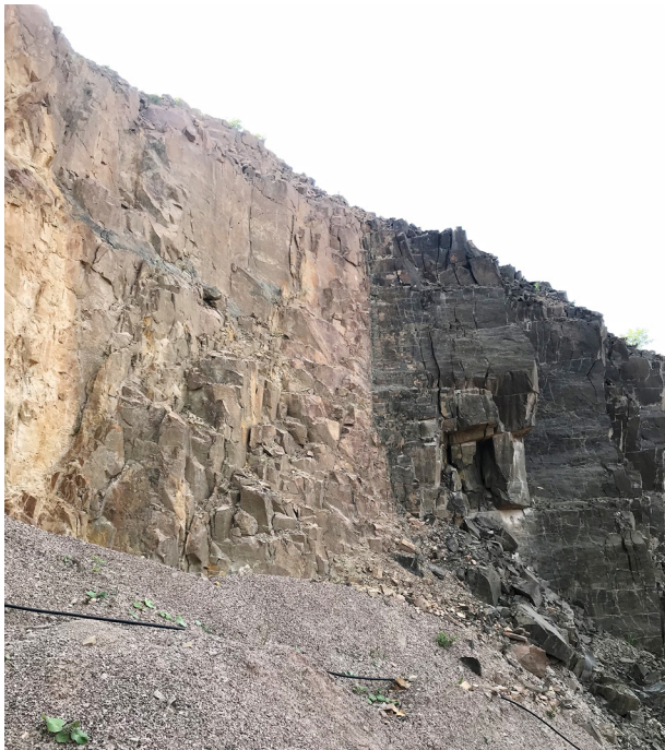
Figur 18. Nästan alla bergtäkter i Sverige innehåller mer än en bergart. Vissa bergarter har mycket goda tekniska egenskaper varför de kan användas till speciella produktområden, till produkter som är mer ekonomiskt värdefulla än andra. Till vänster i bilden syns den finkorniga granitoiden som bryts i Norra Rörum för produktion av slitlagersten och helkrossad ballast för betong. Den mörka dioriten till höger i bilden är mer lämplig för andra användningsområden varför bergarterna bryts var och en för sig. Foto: Lena Lundqvist, SGU.
