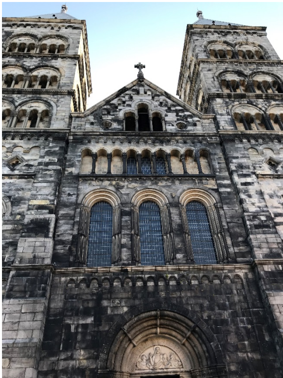
Figur 8. Lunds domkyrka är till stor del byggd av Höörsandsten. Ett material som inte behövde transporteras långt för att kunna användas i byggnationen. Foto: Gry Møl Mortensen, SGU.
