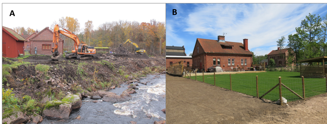
Figur 18. Sanering av Rydöbruk i Hylte kommun. A. Rydöbruk är en värdefull kulturmiljö och saneringen har utförts på ett sådant sätt att byggnaderna inte skadats. Foto: Erik Bergstedt, SGU. B. Saneringen har gett möjlighet till att utveckla användningen av området samtidigt som dess karaktär finns kvar. Foto: Erik Bergstedt, SGU.
