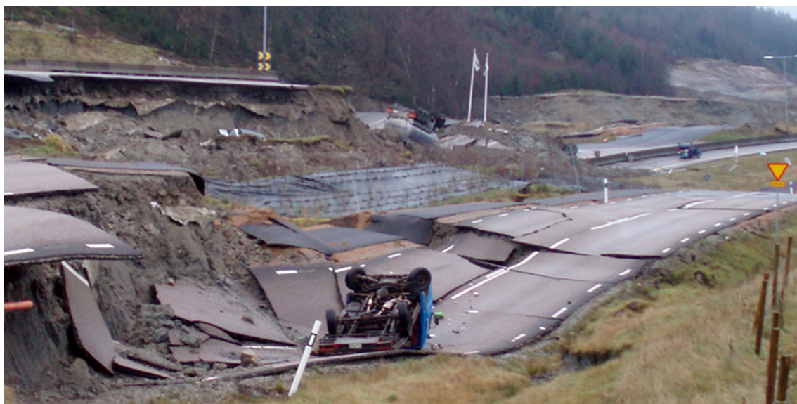
Figur 3. Skredet i Småród i Bohuslän inträffade 20 december 2006 och drabbade infrastruktur (E6) och passagerare i förbipasserande bilar och tåg. Orsaken till skredet var uppläggning av schaktmassor i ett skredkänsligt område. Foto: SGI, 2006.
